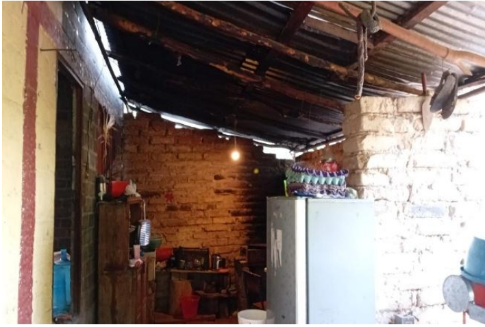
Fotografía 1. Se realizo la visita para revisión de Techos varias Localidades
