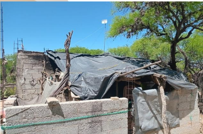
Fotografía 1.2. Se realizo la visita para revisión de Techos varias localidades
