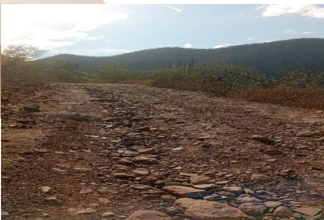
Fotografía 7. Revisión de caminos para rehabilitación
