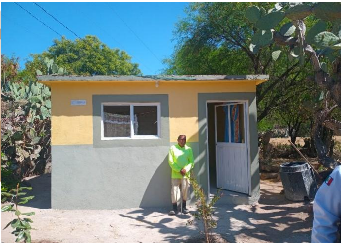
Fotografía 3. Se realizo la entrega de Cuartos Dormitorios
