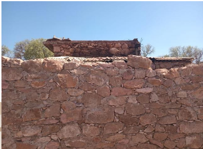
Fotografía 1.1. Se realizo la visita para revisión de Techos varias localidades
