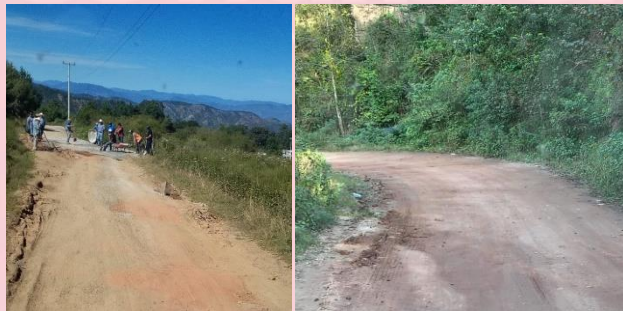
REHABILITACION DE CAMINOS (COMUNIDAD PUERTO DE PALMAS)
