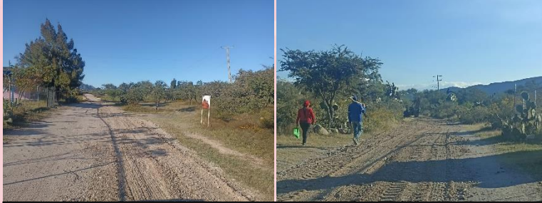
REHABILITACION DE CAMINOS (COMUNIDAD EL PITAHAYO)
