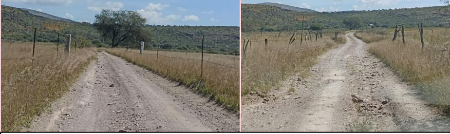
REHABILITACION DE CAMINOS (CAMINO DE LA LUZ AL PITAHAYO)
