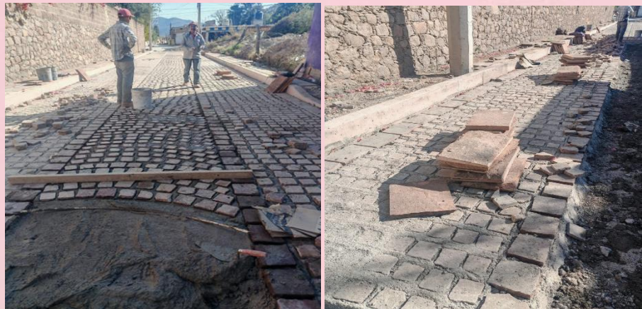
CONSTRUCCION DE CALLE 16 DE SEPTIEMBRE
