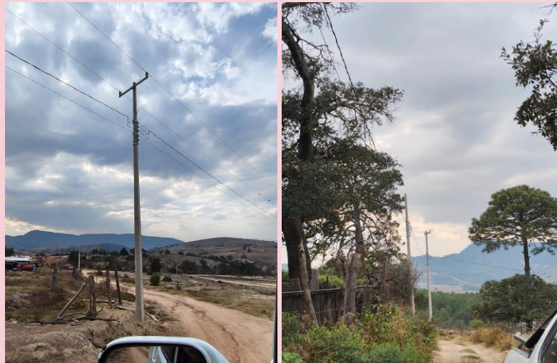
AMPLIACION DE ELECTRIFICACION JERONIMO
