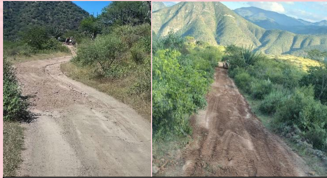
REHABILITACION DE CAMINOS (CAMINO DE MESA PRIETA AL SABINO)
