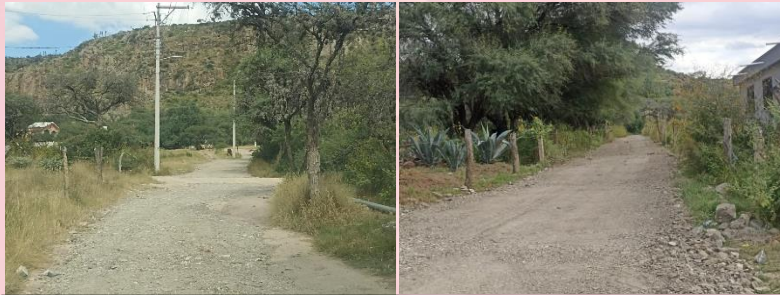
REHABILITACION DE CAMINOS (COMUNIDAD PALMILLAS)
