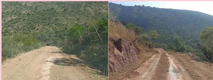
REHABILITACION DE CAMINOS (COMUNIDAD EL CARRIZO)
