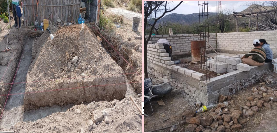
CONSTRUCCION DE CUARTOS DORMITO
