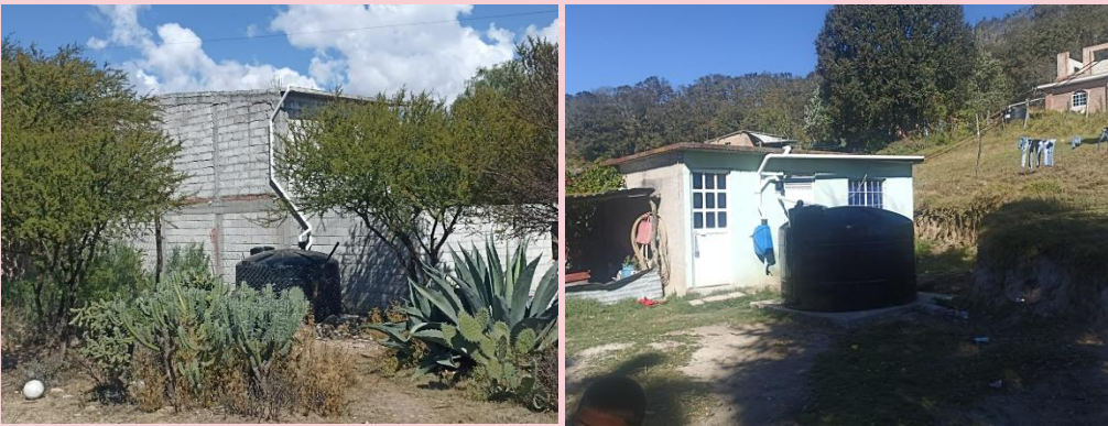
CONSTRUCCION DE CISTERNAS EN DIFERENTES LOCALIDADES
