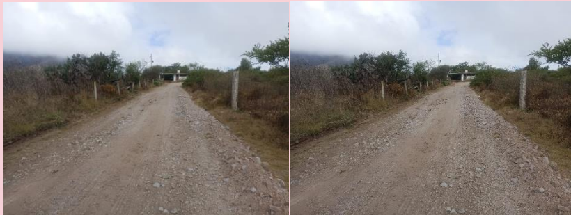
REHABILITACION DE CAMINOS (COMUNIDAD MESITA DEL TIGRE)
