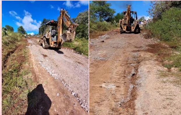
REHABILITACION DE CAMINOS (CAMINO DE LOMA DE LOS CHILITOS A MILPILLAS DEL PITO)
