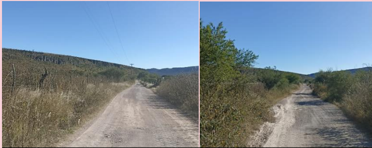
REHABILITACION DE CAMINOS (CAMINO DE LAS TROJES A MESITA DEL TIGRE)
