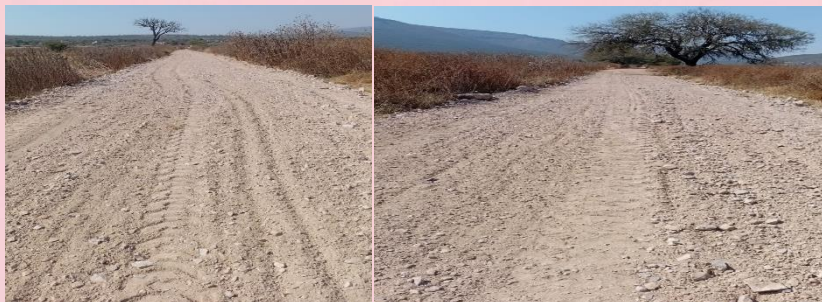
REHABILITACION DE CAMINOS (CAMINO DE CAÑADA DE MORENO A LA ESPERANZA)
