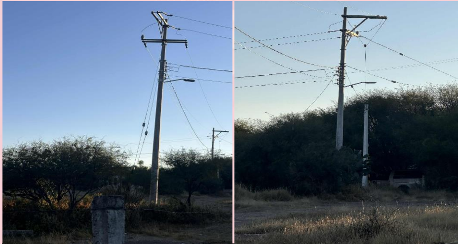
AMPLIACION DE ELECTRIFICACION EN CIENEGUILLA
