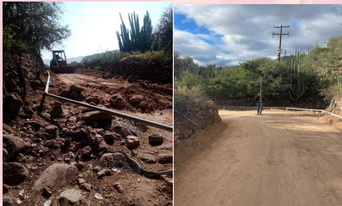
CONSTRUCCION DE CALLE CAMINO REAL EN MILPILLAS DE
