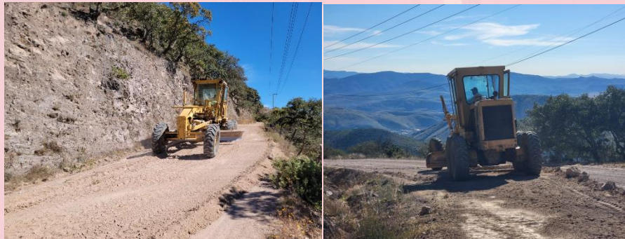
REHABILITACION DE CAMINOS (CAMINO DE LAS HELADAS A CAÑADA DE HIGUERAS)
