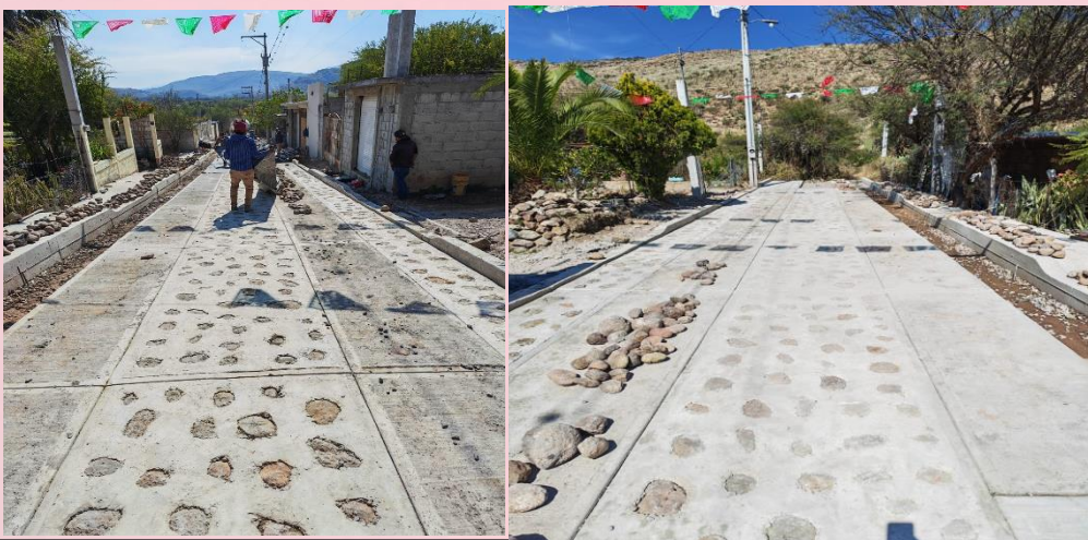
CONSTRUCCION DE CALLE LA CASCADA EN EL TASAJILLO
