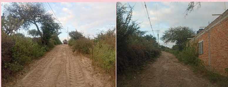
REHABILITACION DE CAMINOS (COMUNIDAD NEGRITAS)
