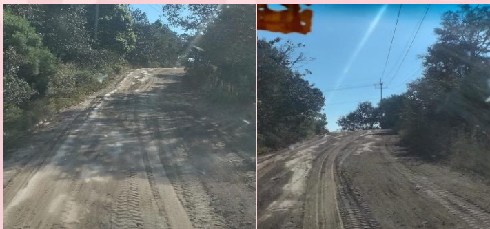
REHABILITACION DE CAMINOS (CAMINO DE LAS HELADAS)
