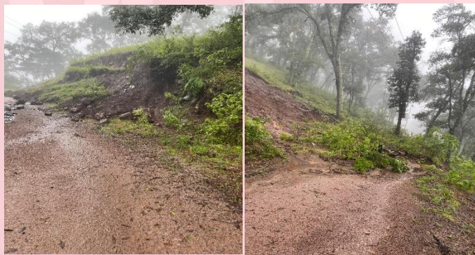
REHABILITACION DE CAMINOS (LA YERBABUENA)
