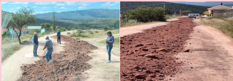
REHABILITACION DE CAMINOS (LA GAVIA CHICA)
